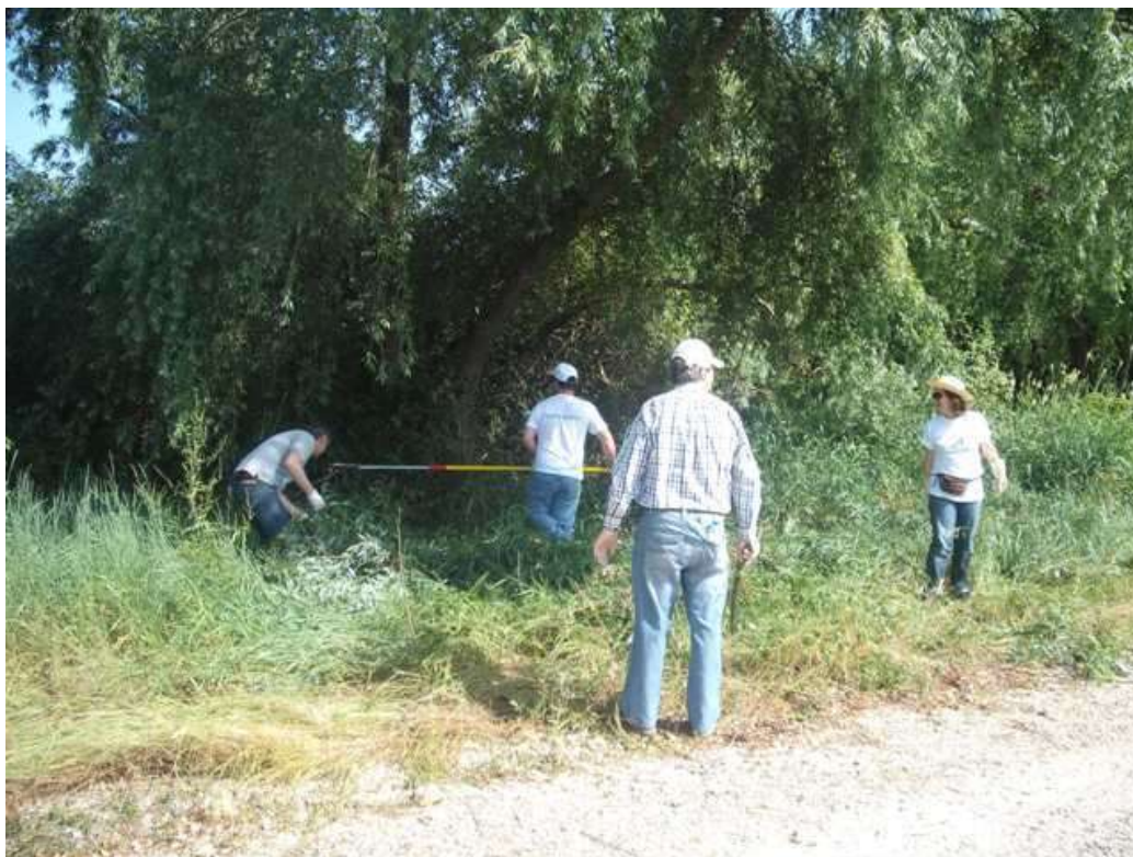
Outro aspecto dos trabalhos de recuperação da maracha do Patacão, em 21 de Maio de 2010. Neste dia trabalharam 27 pessoas, numa primeira acção de voluntariado
